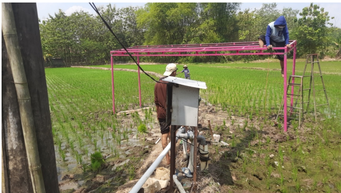
Gambar 2. Pemasangan rangka panel surya untuk sistem irigasi pertanian di lahan sawah Desa Guli
