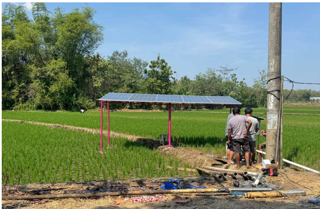
Gambar 3. Pendampingan instalasi panel surya sebagai sumber energi pompa irigasi pertanian di Desa Guli
